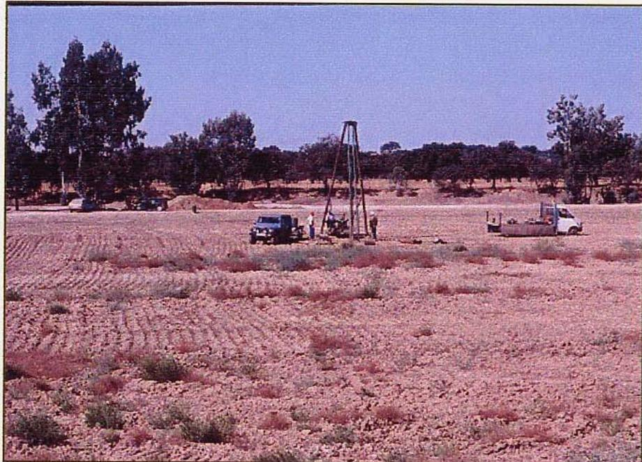
*Perforación de piezómetro n° 8 mediante percusión con válvula de succión.*
