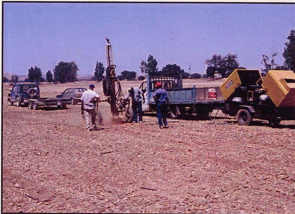
*Perforación de sondeo de investigación n° 14, con sonda neumática.*
